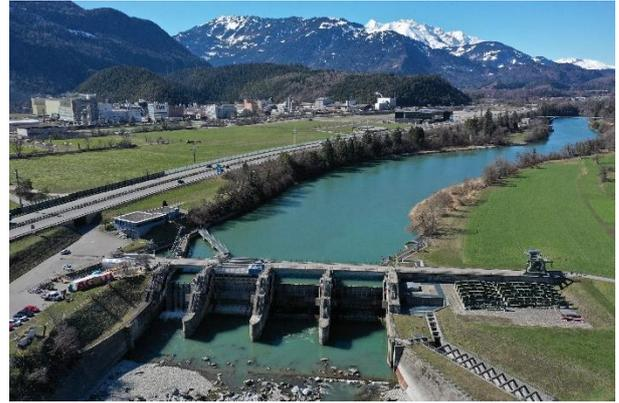
Abb. 3.4: KW-Reichenau - mit Stau und RW-Strecke (© hydra)
