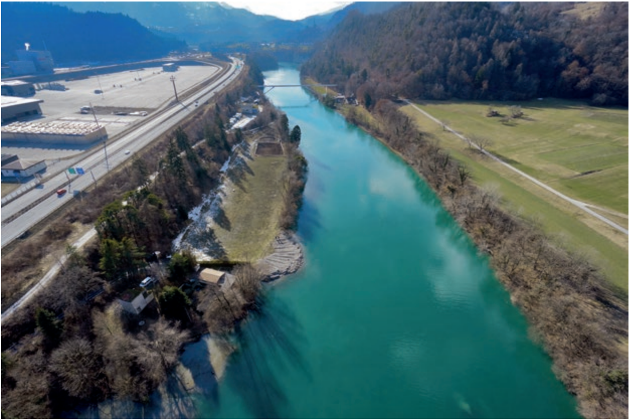
Abb. 78: Alpenrhein innerhalb des Staus des Kraftwerks Reichenau (Axpo) auf Höhe Domat/Ems (GR). Unten links die kantonale Fischzuchtanlage. Blick flussaufwärts. Foto: HYDRA 2015 ©.
