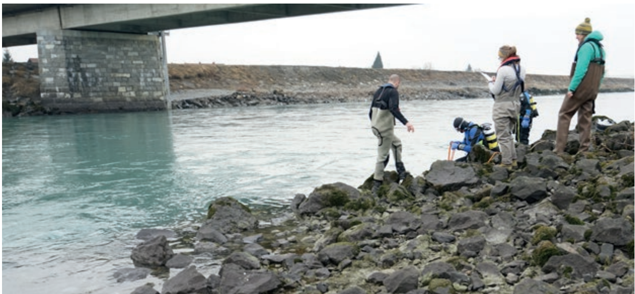
Abb. 110: Untersuchungsstelle ARH-Lustenau. Blick auf der rechten. Foto: HYDRA 2015 ©.
