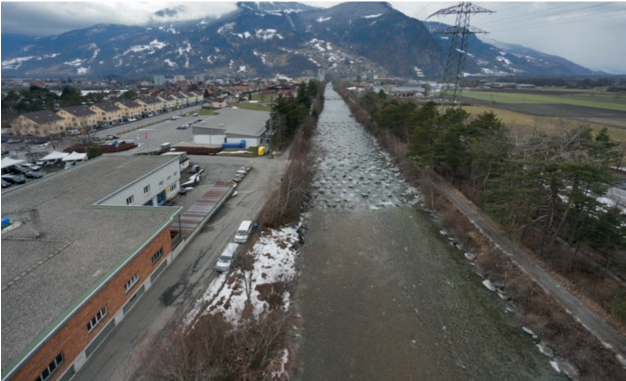
Abb. 90: Die Landquart oberhalb des Siedlungsbereichs von Igis-Landquart (GR) uh. Chur. Blick flussabwärts. Foto: Rheos 2015 ©.
