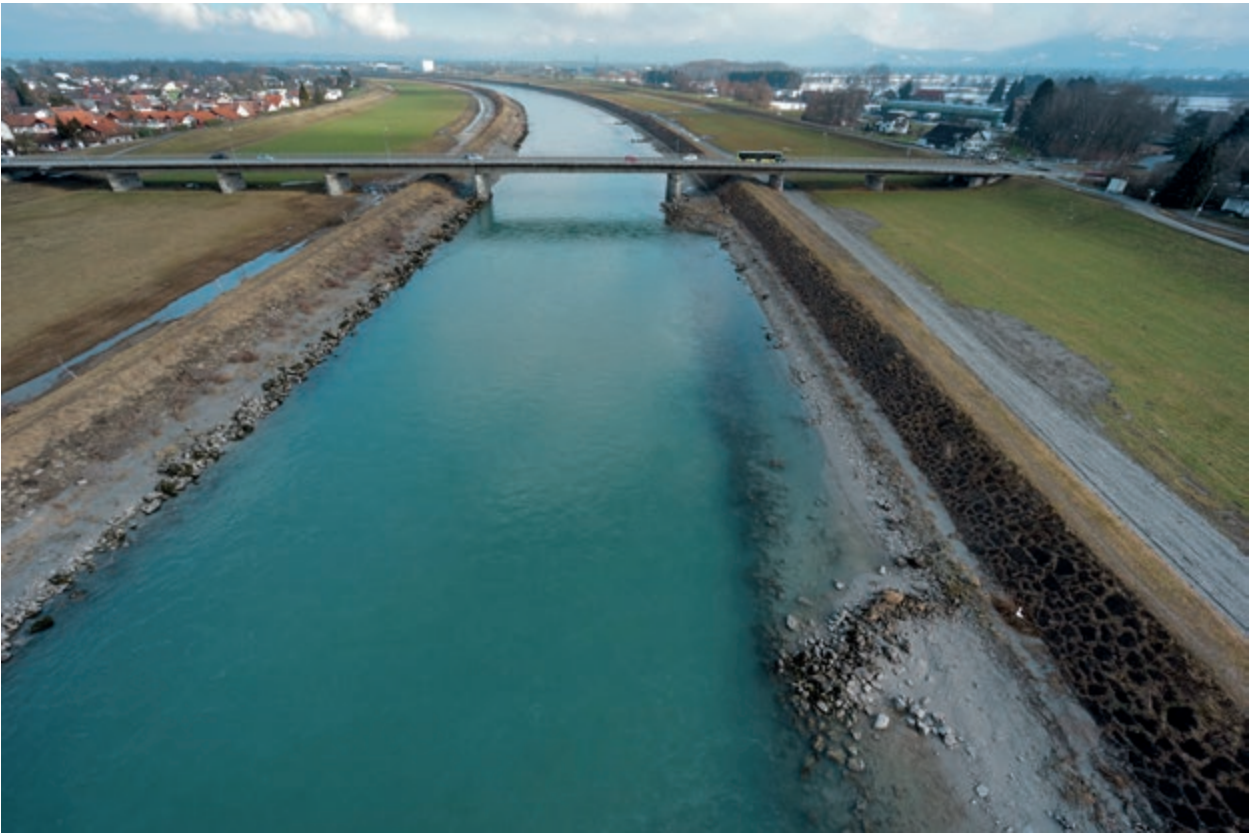
Abb. 109: Alpenrhein bei Lustenau (Vorarlberg). Oben im Bild die Brücke Höchst-Lustenau. Foto: Rheos 2015 ©.
