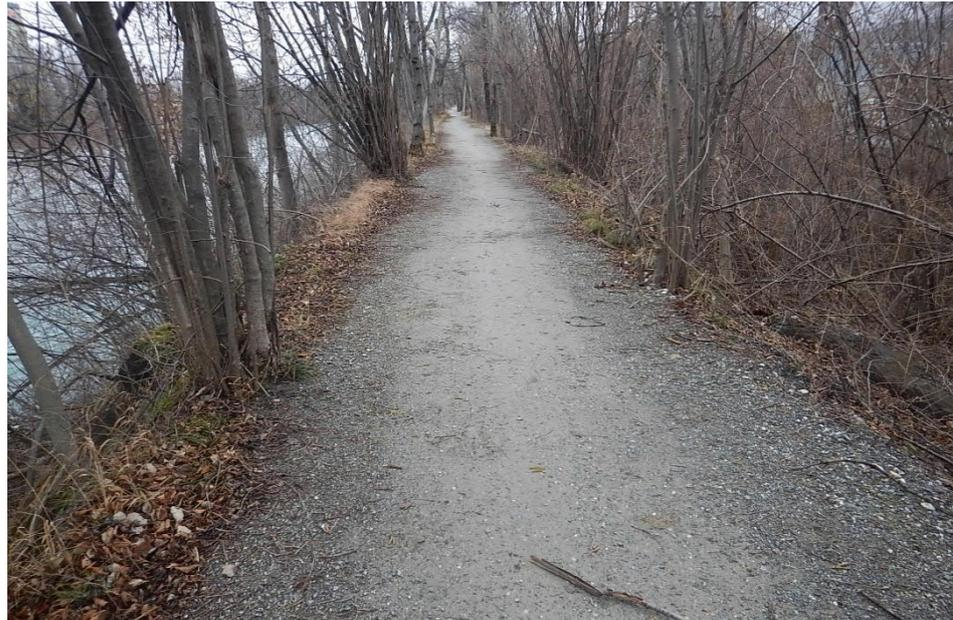
Abbildung 9: Rechter Damm ca. bei km 16.7, Trimmis Industrie, Blickrichtung flussabwärts. Der Damzustand ist vermutlich mangelhaft, und am wasserseitigen Prallhang ist vermutlich ein starker Erosionsdruck vorhanden. Sanierung Damm und Uferschutz sowie Dammerhöhung rund 30 cm (Foto NIPO, Jan. 2020)
