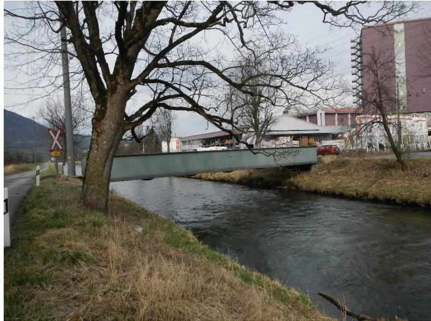
Abbildung 23: WBK im Bereich der Industriezone Hofwald; kleine beidseitige Ufererhöhungen und Dammbalkenverschlüsse bei der Gleisbrücke im Hintergrund (Foto NIPO, Feb. 2020, Blickrichtung kanalabwärts).
