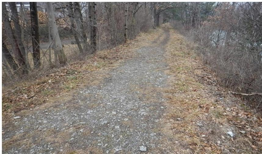
Abbildung 8: *Linker Damm ca. bei km 17.3 unterhalb der Brücke Untervaz, Blickrichtung flussabwärts. Sanierung des schlechten Dammszustands und Dammerhöhung rund 1 m (Foto NIPO, Jan. 2020)*
