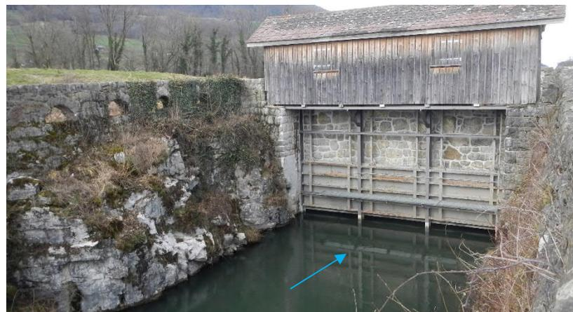
Abbildung 30: Rillisdammschleuse im Rheintaler Binnenkanal. Tafelschützen an der Oberstromseite, geöffnet (Foto NIPO, Feb. 2020).
