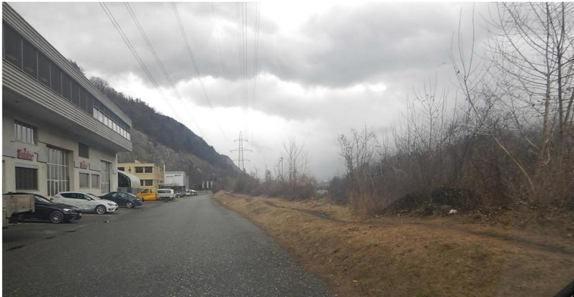
Abbildung 5: Linker, zu verstärkender Damm bei Haldenstein. Schlechter Damzustand.
