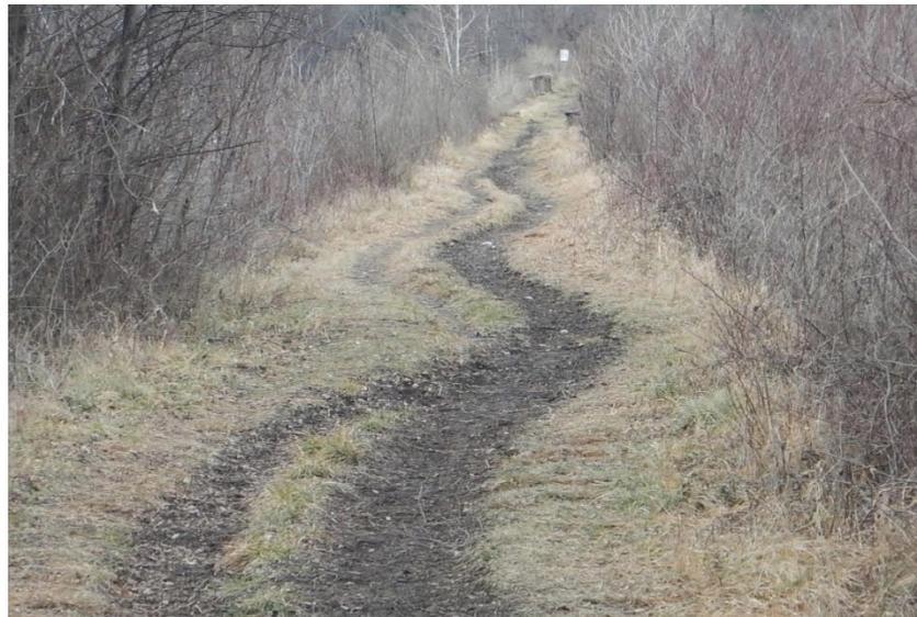
Abbildung 7: *Linker Damm ca. bei km 16.3 oberhalb der Industrie, Blickrichtung flussaufwärts. Sanierung des schlechten Dammszustands durch leichte Absenkung und Ausflachung (Foto NIPO, Jan. 2020)*
