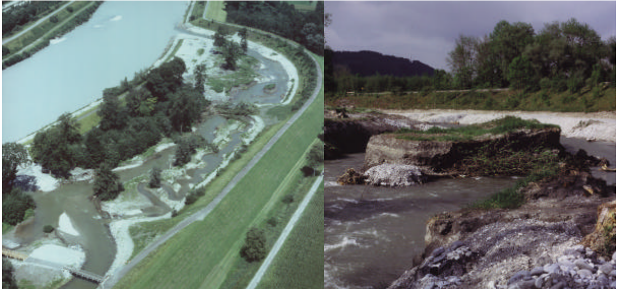
Abb. 4.32: Umgebauter Mündungsbereich des Liechtensteiner Binnenkanals in den Alpenrhein.
