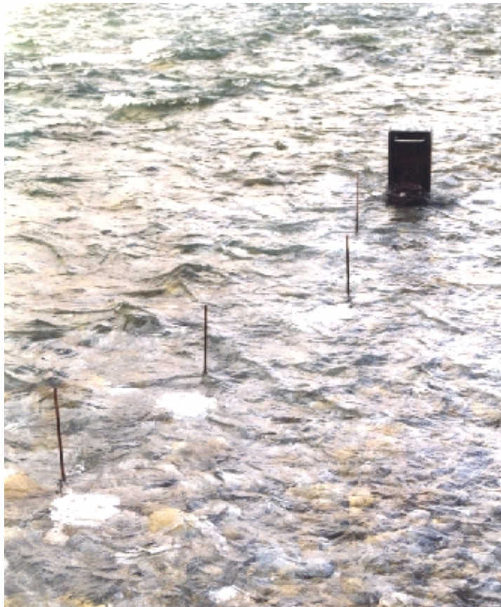
Abb. 5.4: Die Kästen werden mit Torstahlstäben gegen Erosion geschützt.
