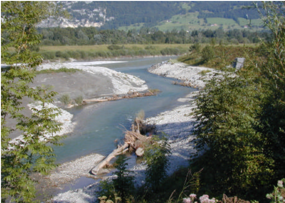
Abb.3.4: Der umgebaute Mündungsbereich des Liechtensteiner Binnenkanals. Im Hintergrund ist der Alpenrhein zu sehen.
