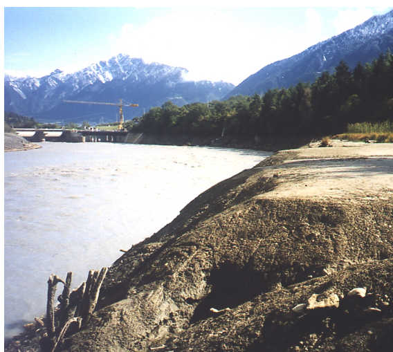
Abb. 22 Feinsedimentbänke entlang des abgesenkten Stauraums Reichenau am 4.10.1999. Blick flussabwärts. Von der Wehrbrücke im Hintergrund aus wurden die Lichtmessungen durchgeführt.
